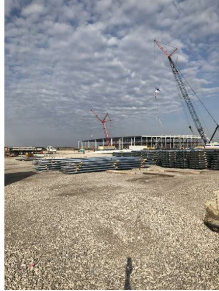
スティランティス工場建設現場
