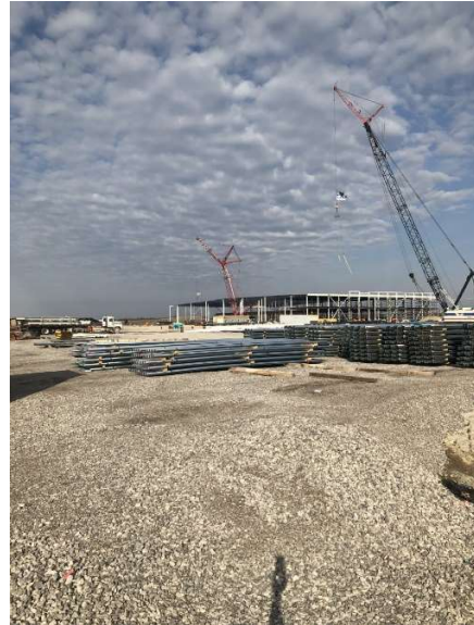
Stellantis Construction Site
